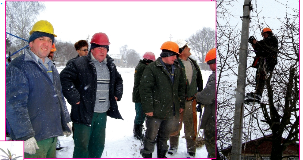
І в негоду напружено працюють бригади електромонтерів
